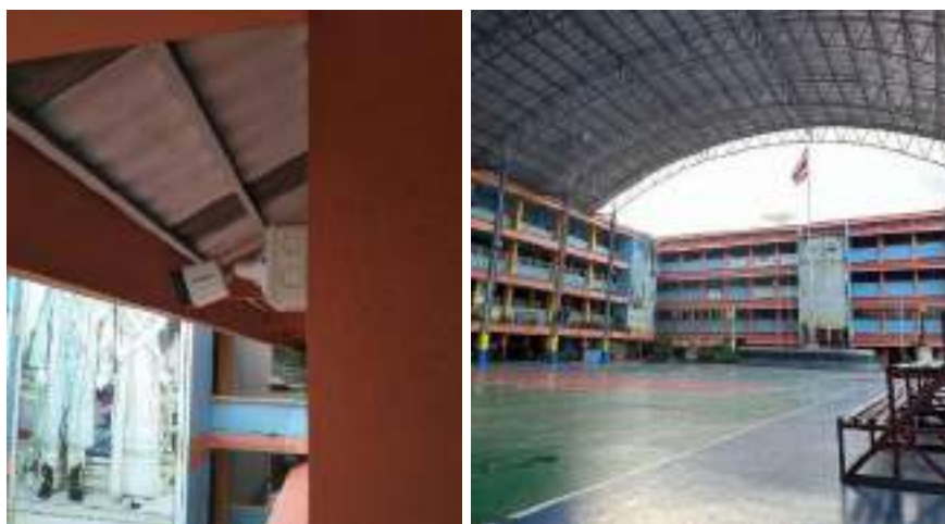
บริเวณแนวด้านหลังลานอเนกประสงค์
