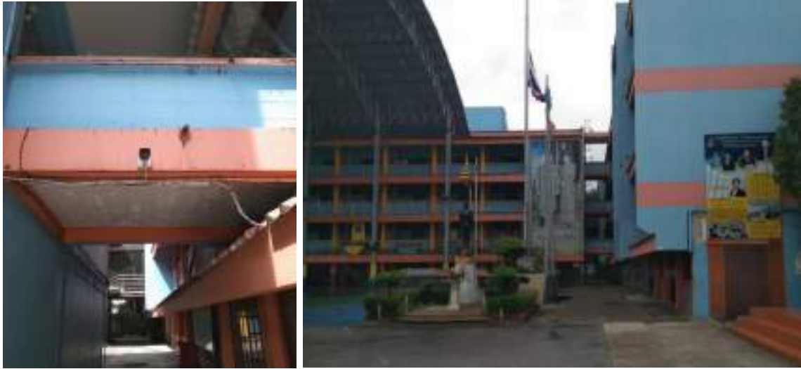
บริเวณหลังอาคาร ๑
